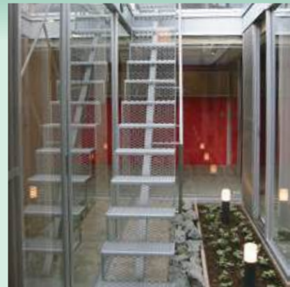
H鋼一本桁階段
