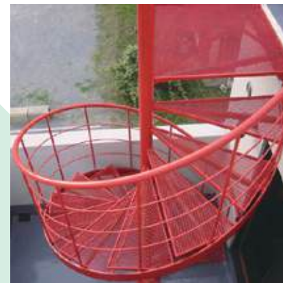
エキスパンドらせん階段(屋上)
