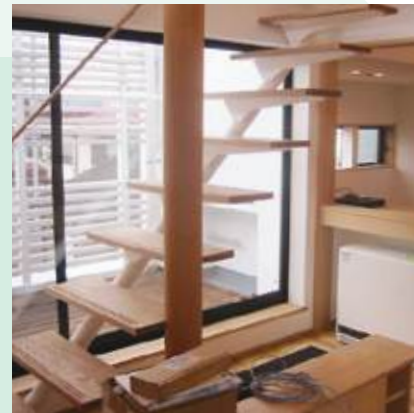
丸パイプ一本桁片寄せ階段
