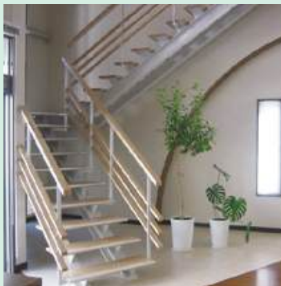
H鋼2本桁階段
