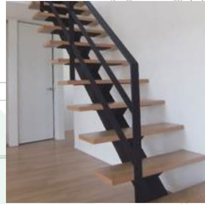
角パイプ一本桁階段。
