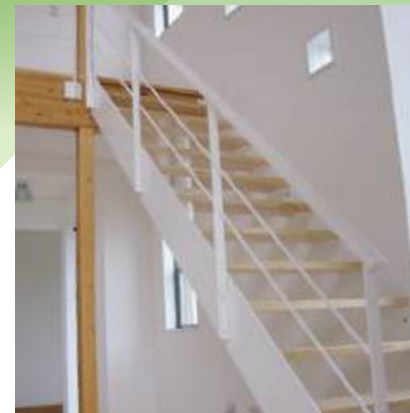
平鋼ささら桁階段③
