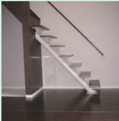
丸パイプ一本桁階段
