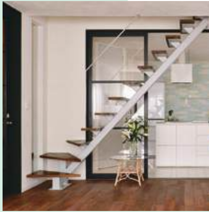
角パイプ・本桁階段(3段曲)
